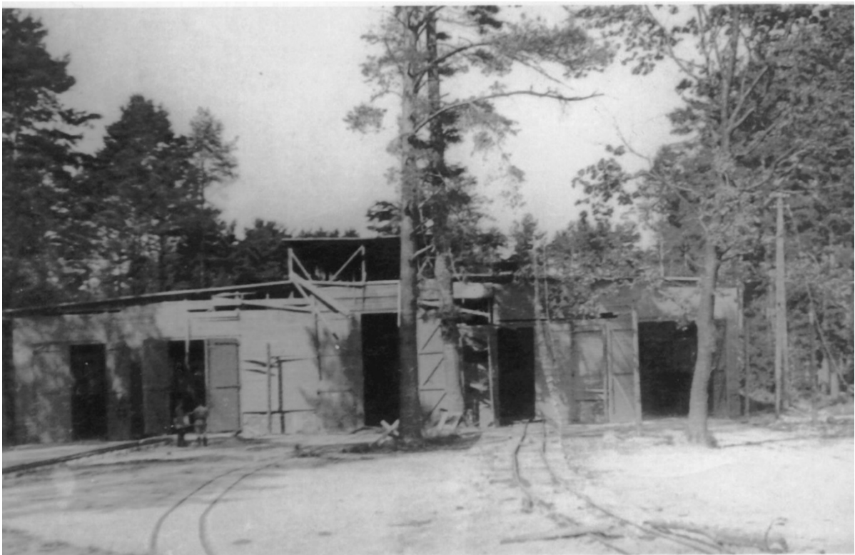
Abbildung 6: Seitenansicht der Montagehalle in Blizna kurz nach dem Krieg [9].
